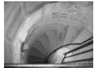
Les escaliers en colimaçon de la tour !
